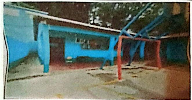
Foto 4: Sustitucion de tendales de madera por costaneras de metal
