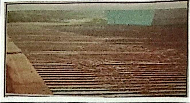
Foto 2: Sustitucion de lamina, por lamina torquelada
