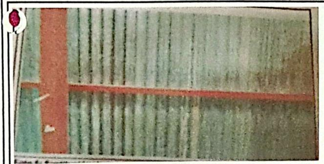
Foto 5: Sustitucion de tendales de madera por tubos de metal
